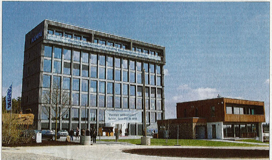
Das Holzhochhaus „K8“, im Vordergrund ein Musterhaus.
