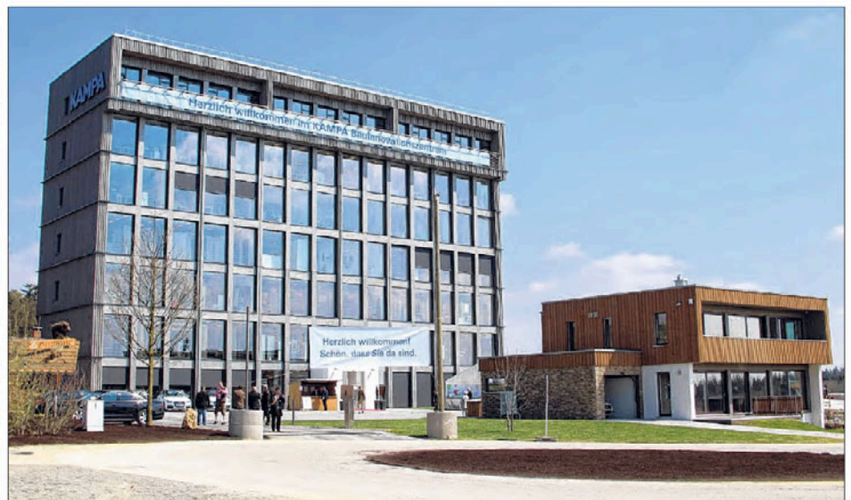
Das Holzhochhaus „K8“, im Vordergrund ein Musterhaus.
